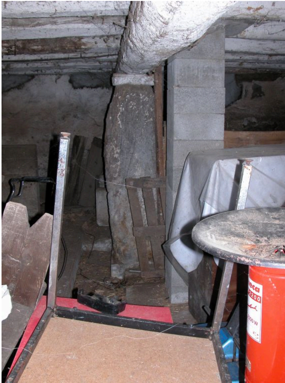
Grange-étable de la ferme du château, détail du pilier monolithe de l'étable.
