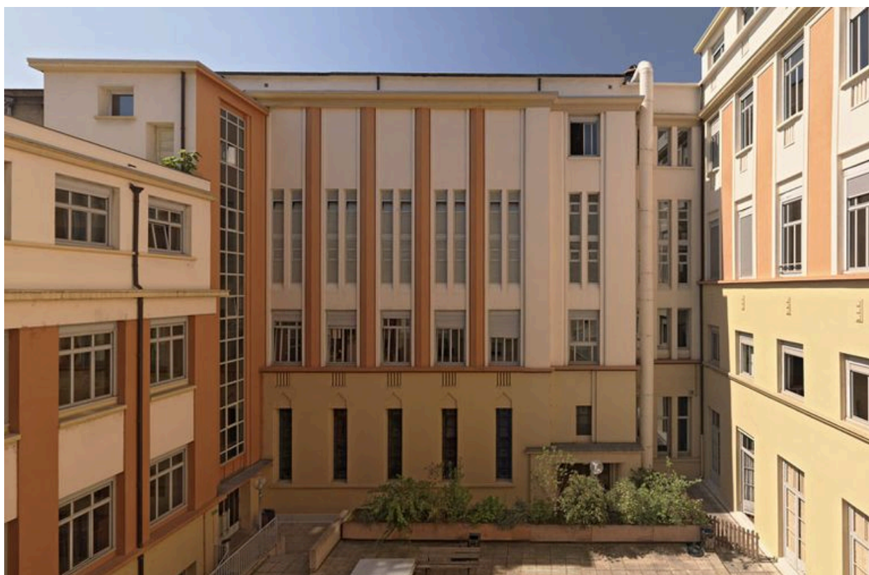
Cour intérieure, vue d'ensemble depuis le nord
