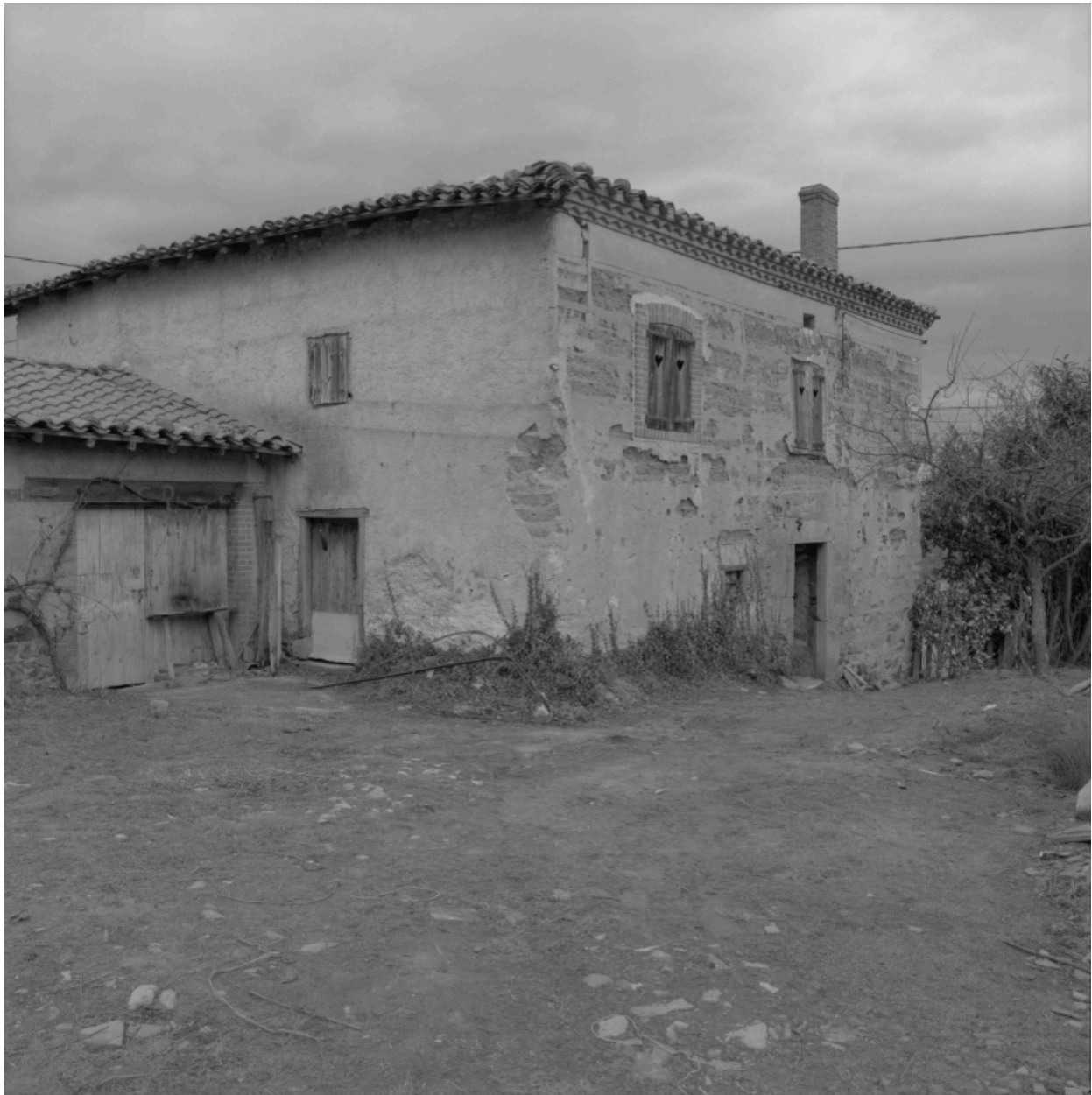
Vue d'ensemble de trois-quarts depuis le sud-ouest.
