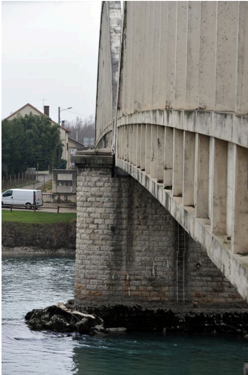
Vue partielle, de côté, pile centrale, face amont (depuis la rive droite)
