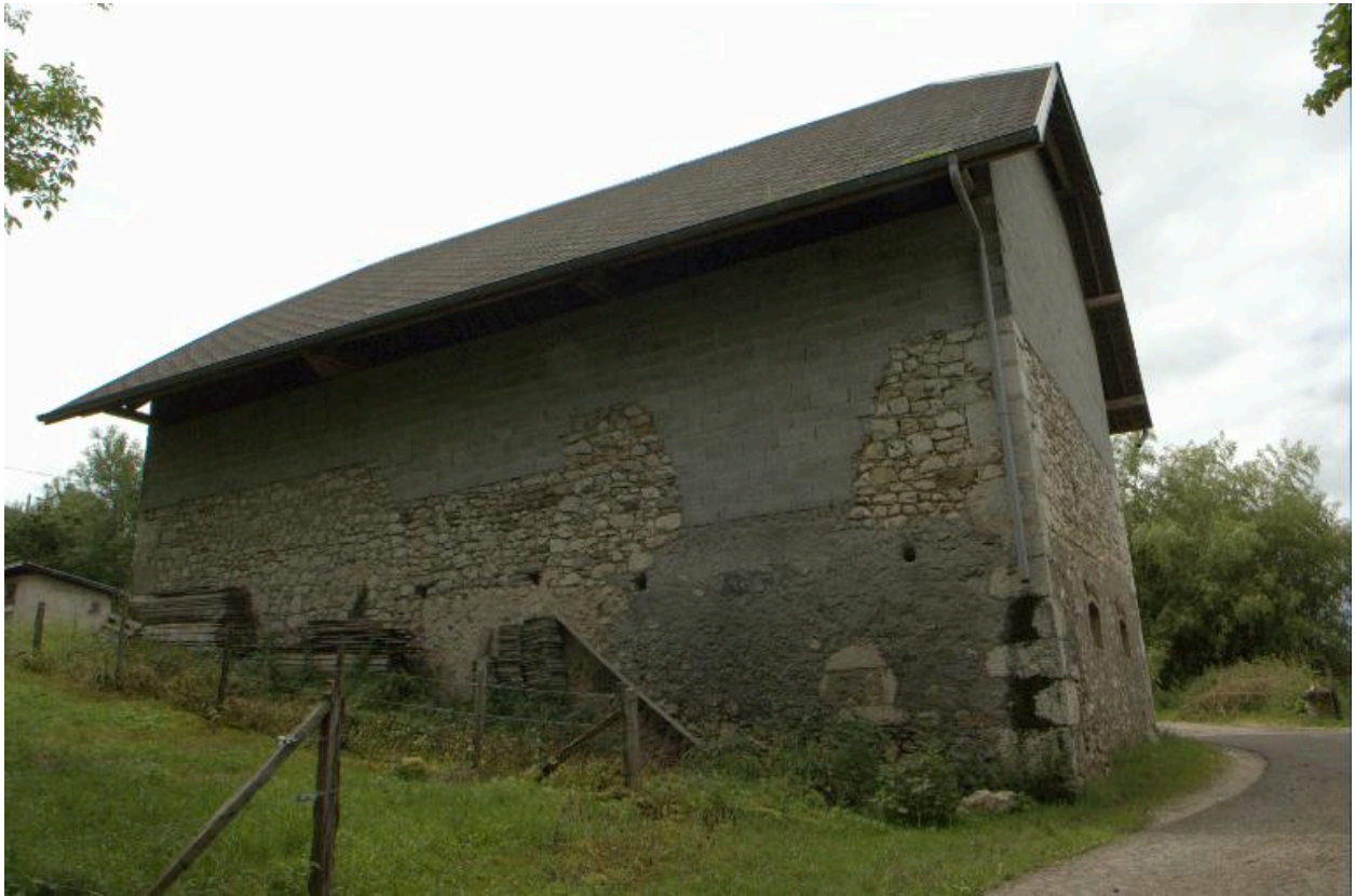
Vue d'ensemble de trois quart avant gauche de la grange-étable.
