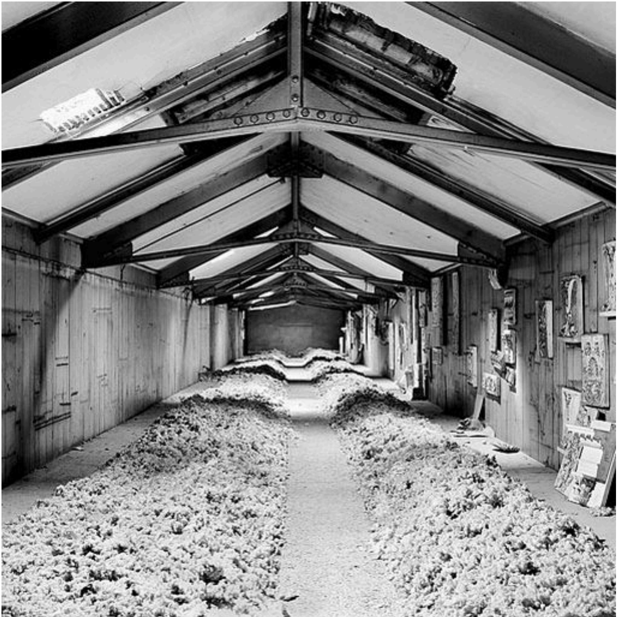
Charpente métallique des anciens locaux de l'école de dessin et modelage
