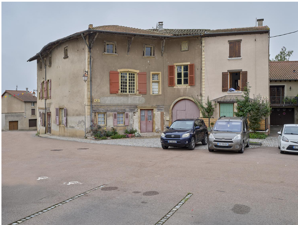
Vue d'ensemble des élévations est et sud de la maison.
