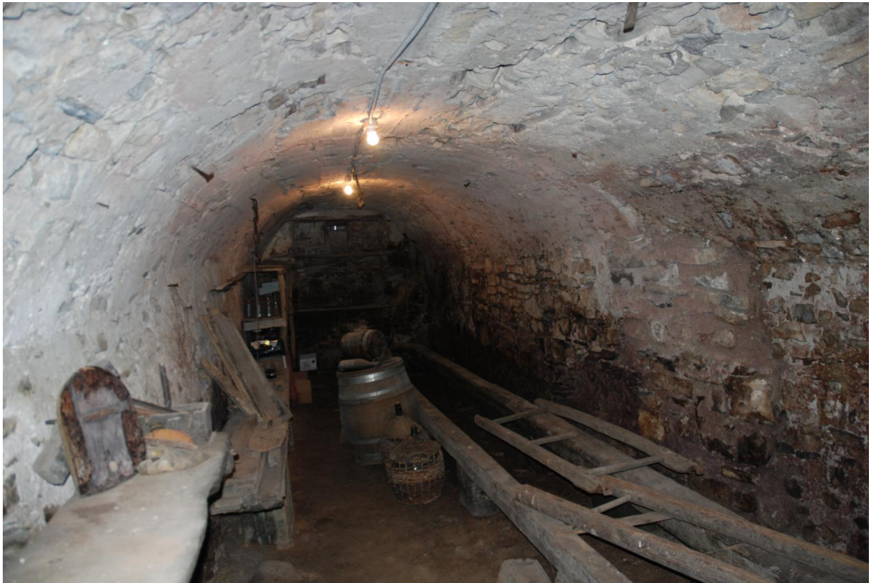
Maison de vigneron (2018 E3 758, 761). Vue intérieure de la cave.
