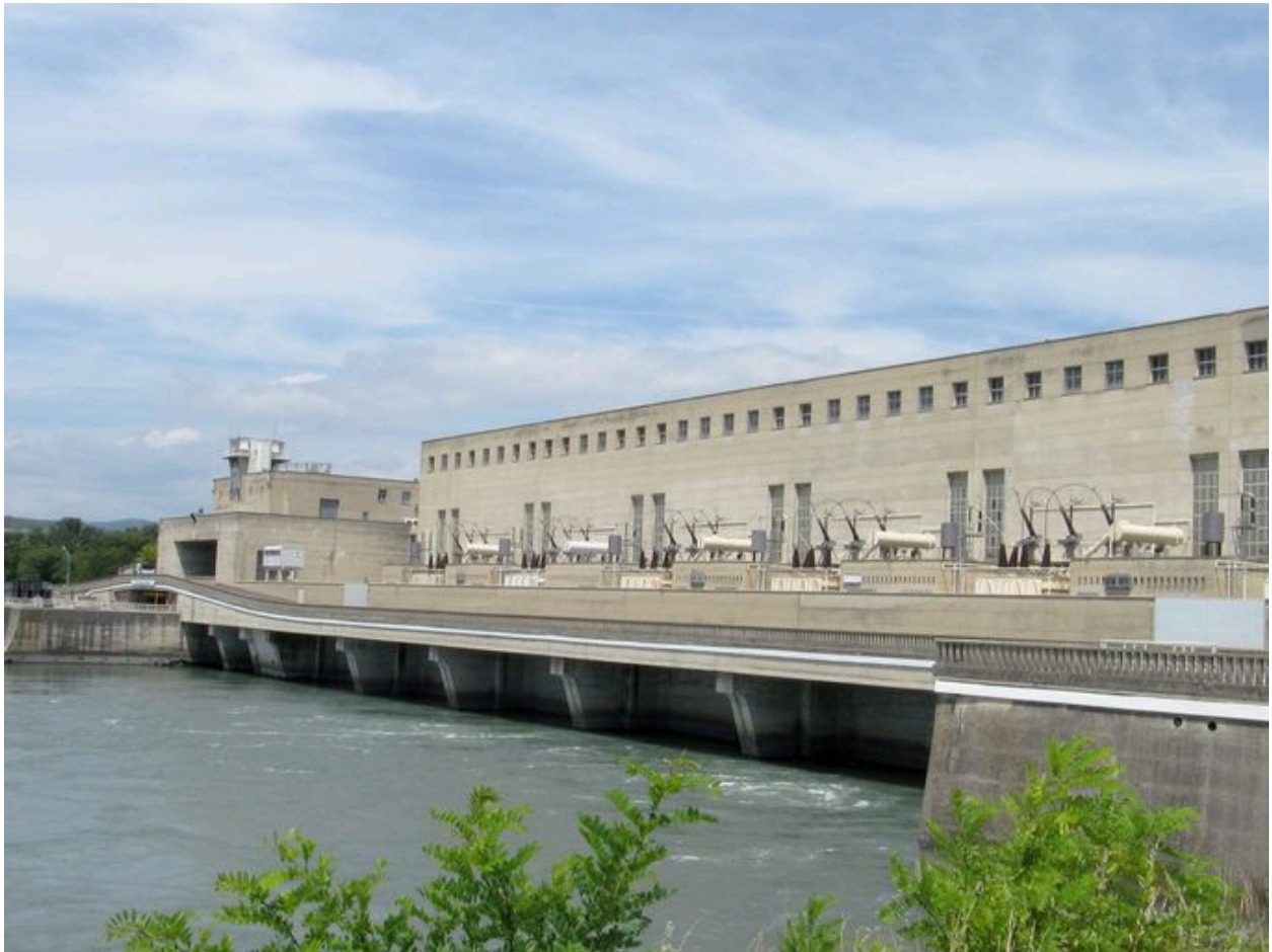
Vue de la centrale et du pont routier, face aval (depuis la rive gauche)
