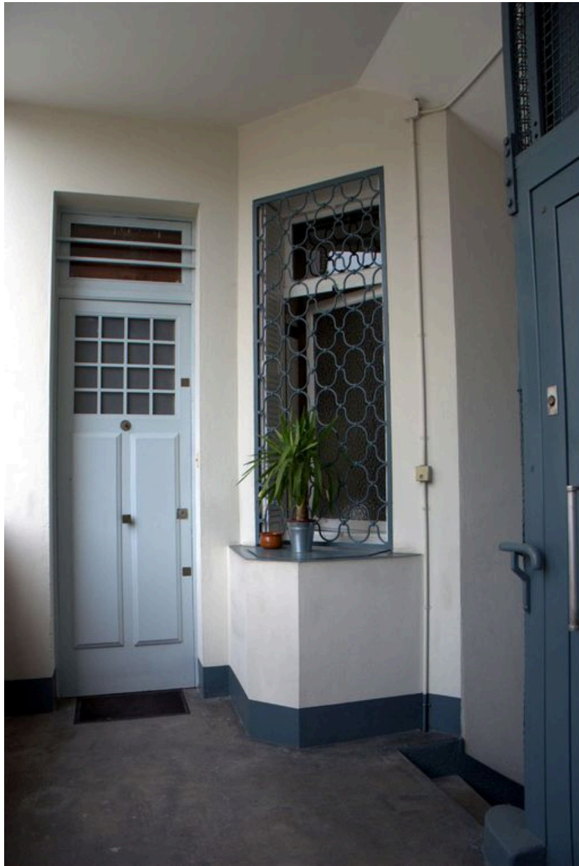
Palier de l'escalier de service, porte palière et fenêtre, depuis l'est
