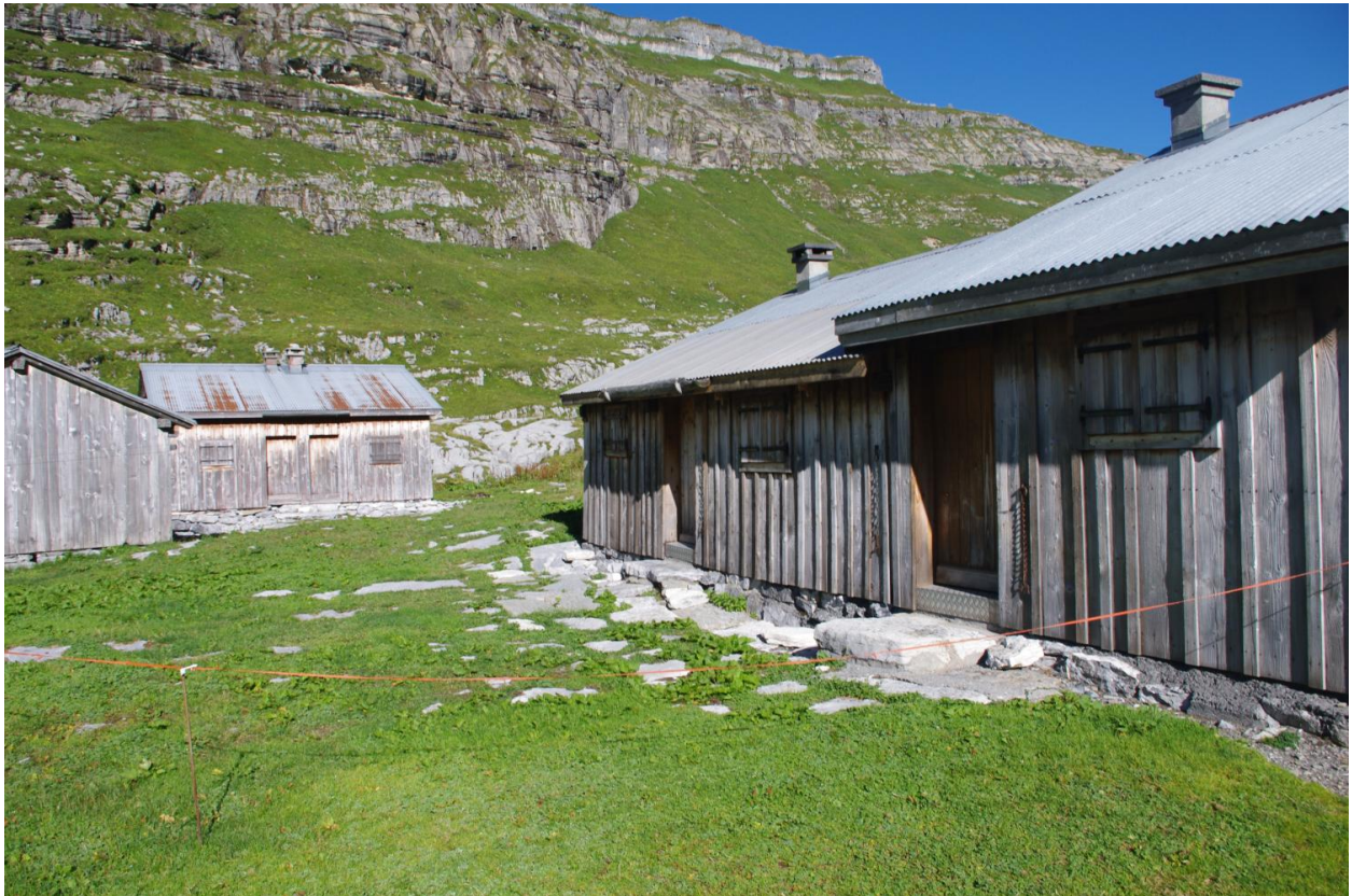
Vue de l'élévation sud-est des deux chalets
