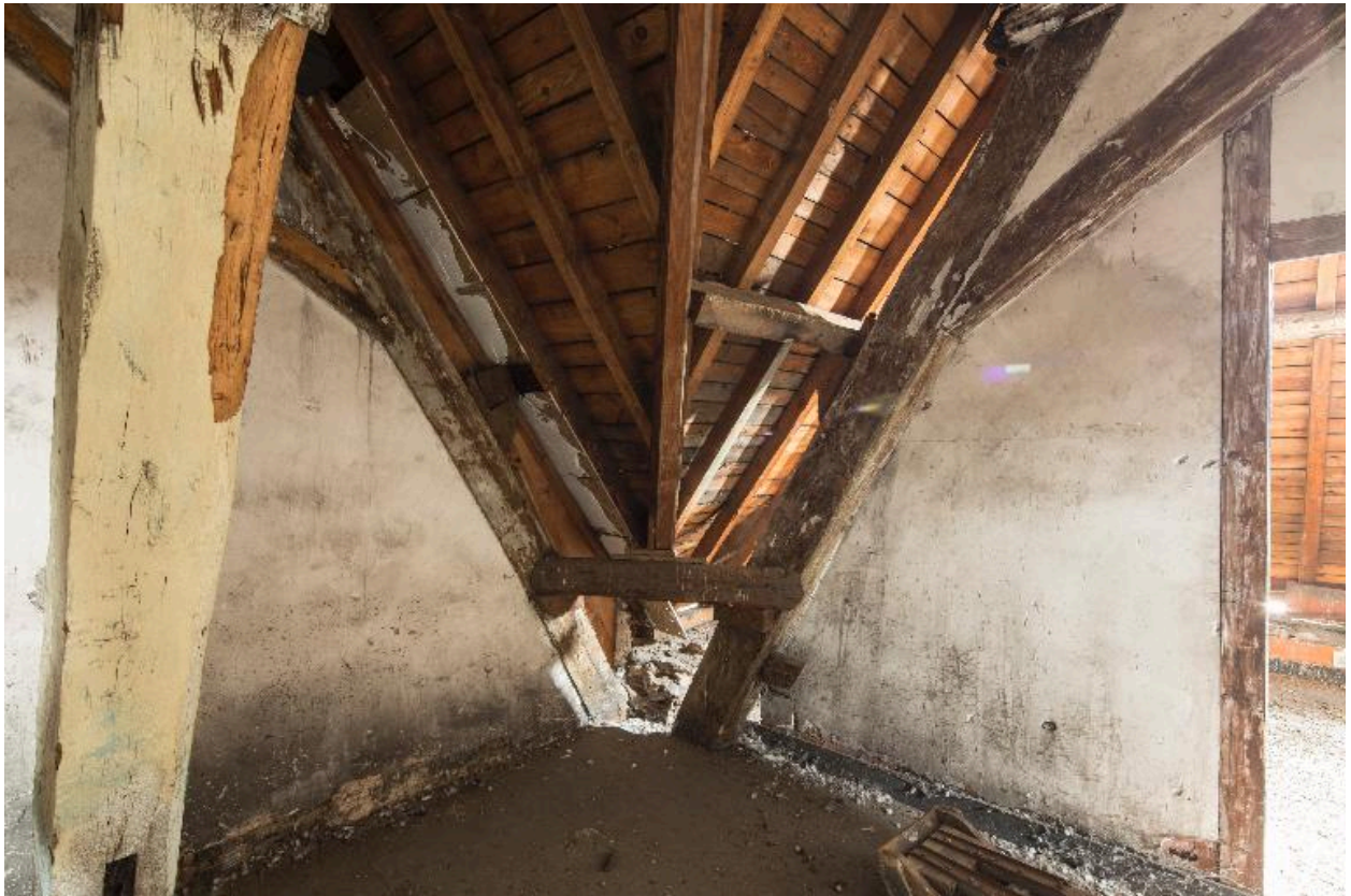
Bâtiment G. Combles : noue
