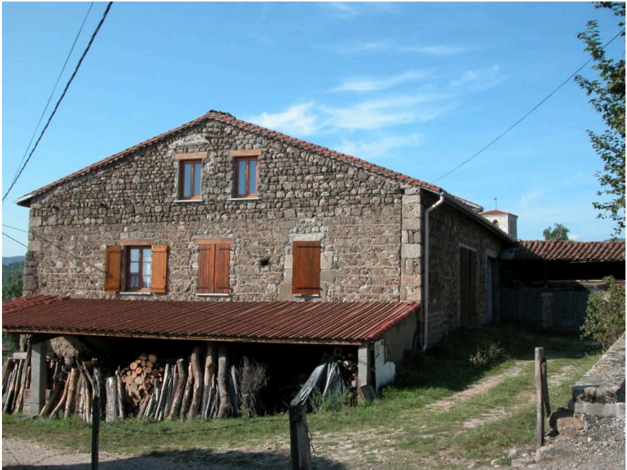
Bourg (le), C 26. Vue arrière de la ferme.
