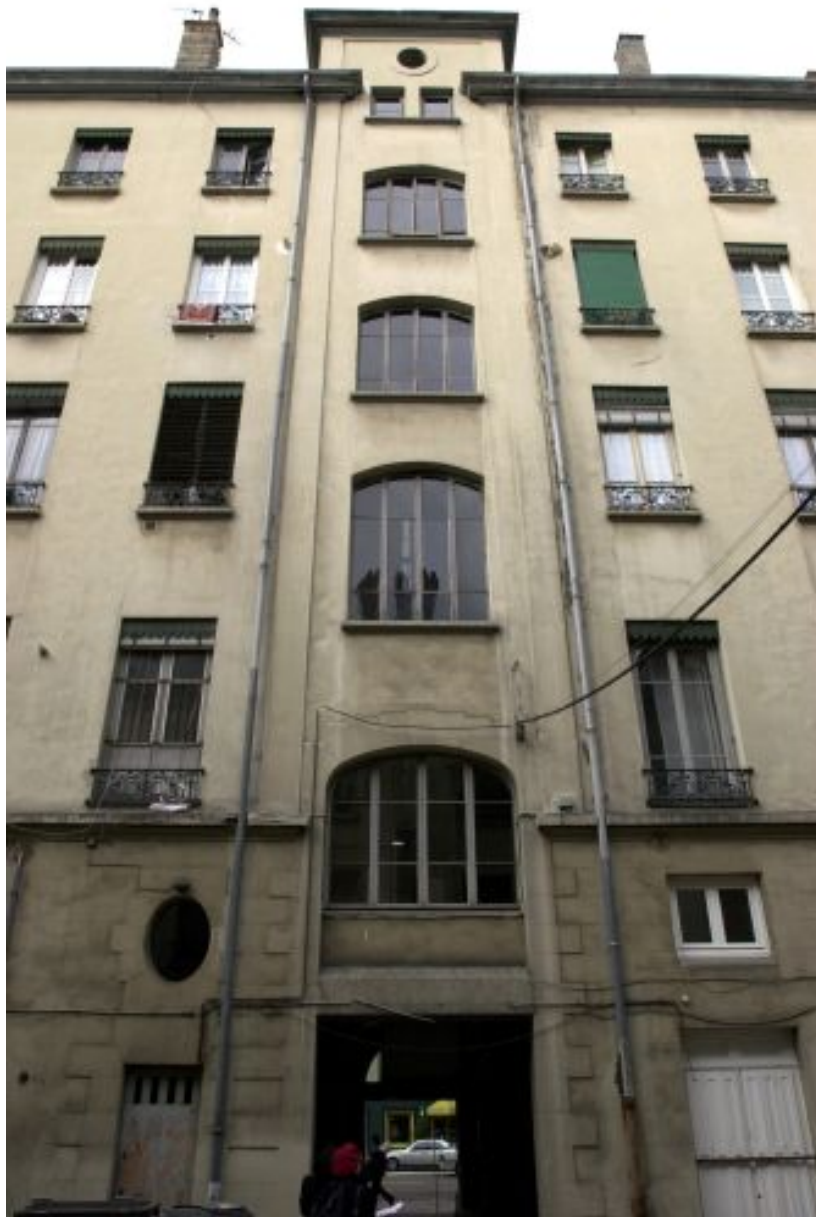
Elévation postérieure de l'immeuble sur rue, vue de la travée d'escalier
