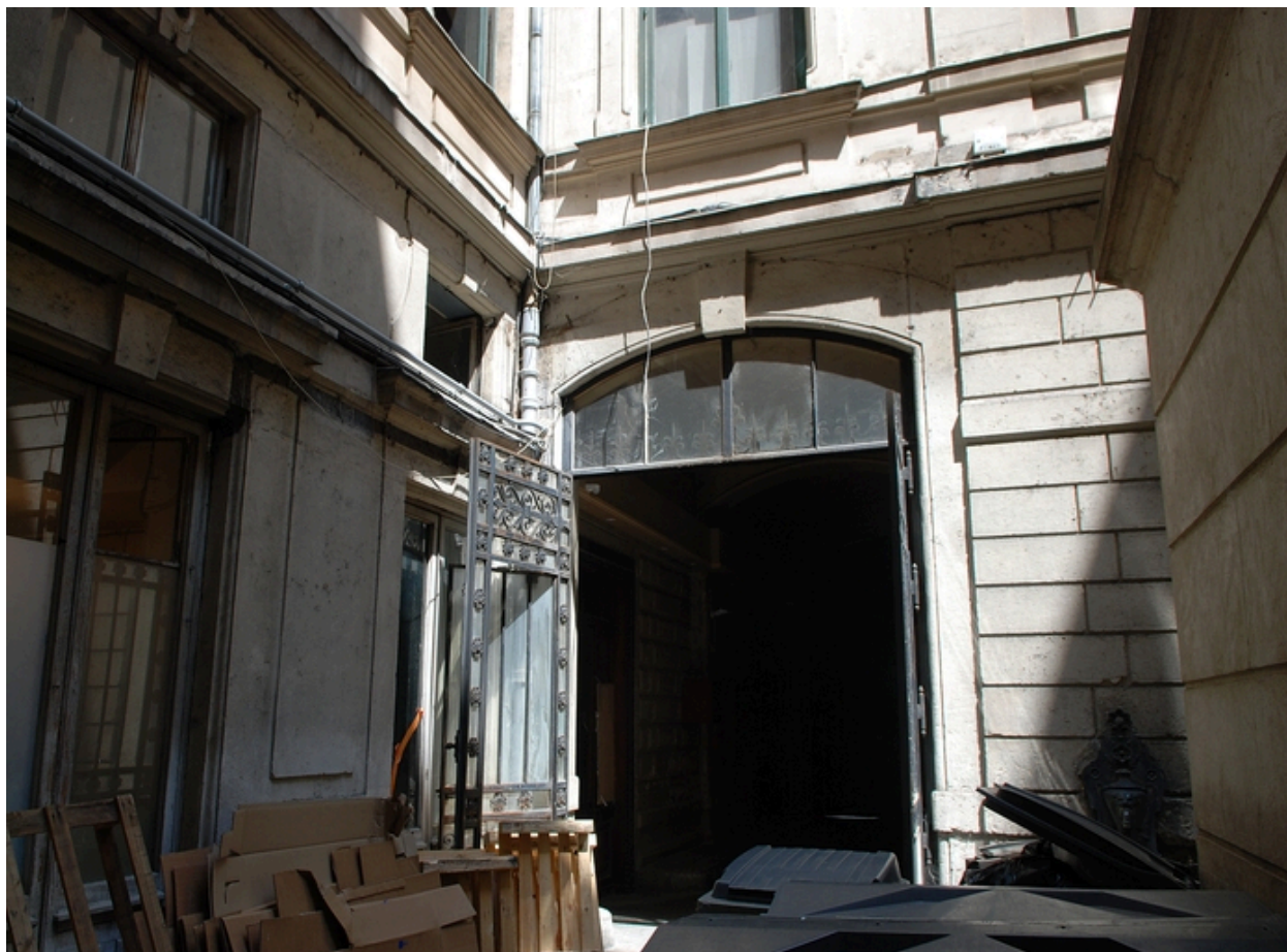
La cour : élévation nord, entrée vers le porche
