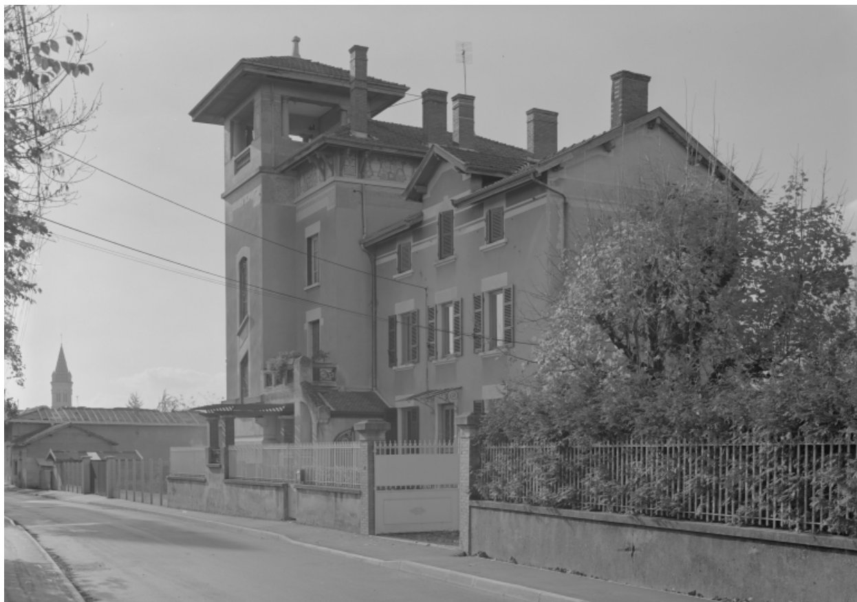
Vue depuis le nord-est, élévation principale.
