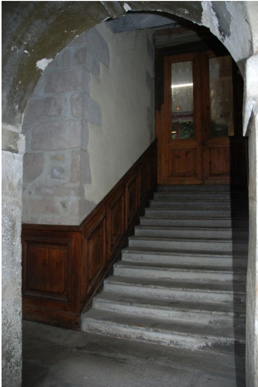
Escalier intérieur : 1ère volée conduisant vers le rez-de-chaussée surélevé.
