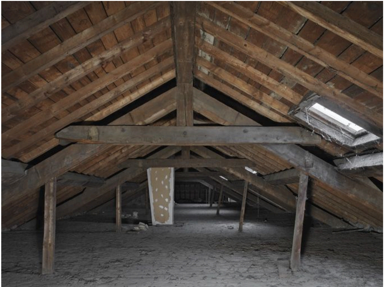
Comble de l'aile nord, depuis l'ouest
