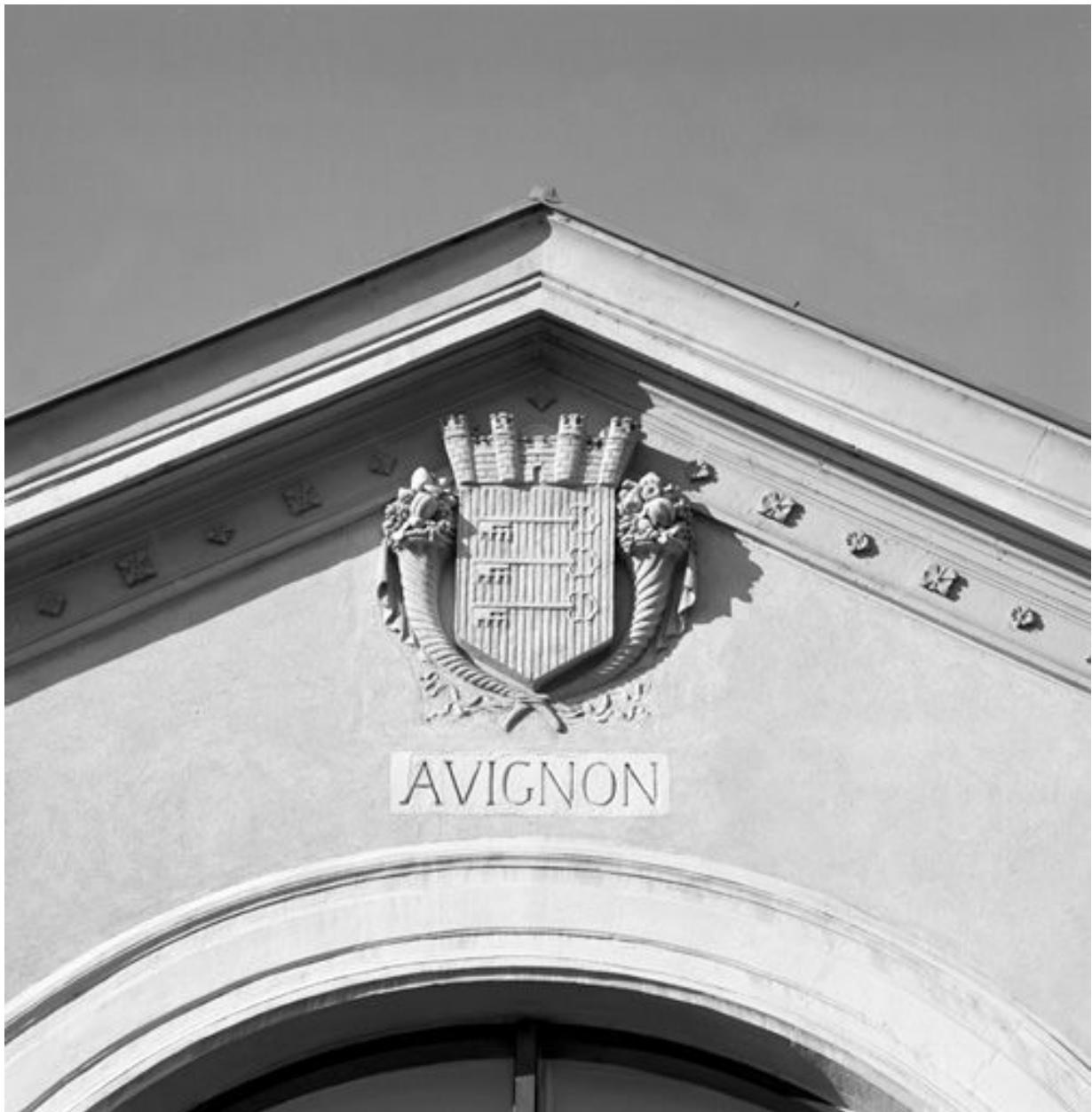
Le bâtiment-voyageurs : bâtiment latéral ouest, écusson aux armes d'Avignon
