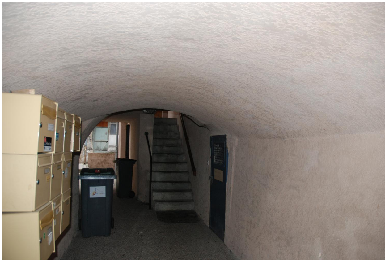
Maison, immeuble, 2 rue Louis Blanc-Pinget ; 11 rue Jean-Louis Bouvet (2018 E1 357, 358, 360). Passage commun sous 2018 E1 358.
