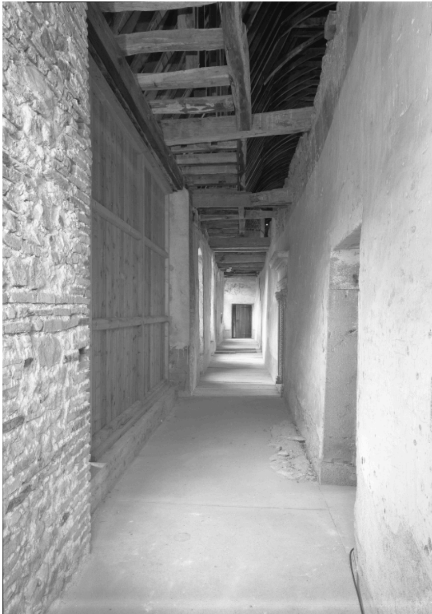
Corps de logis, deuxième étage : vue du corridor, de l'est.
