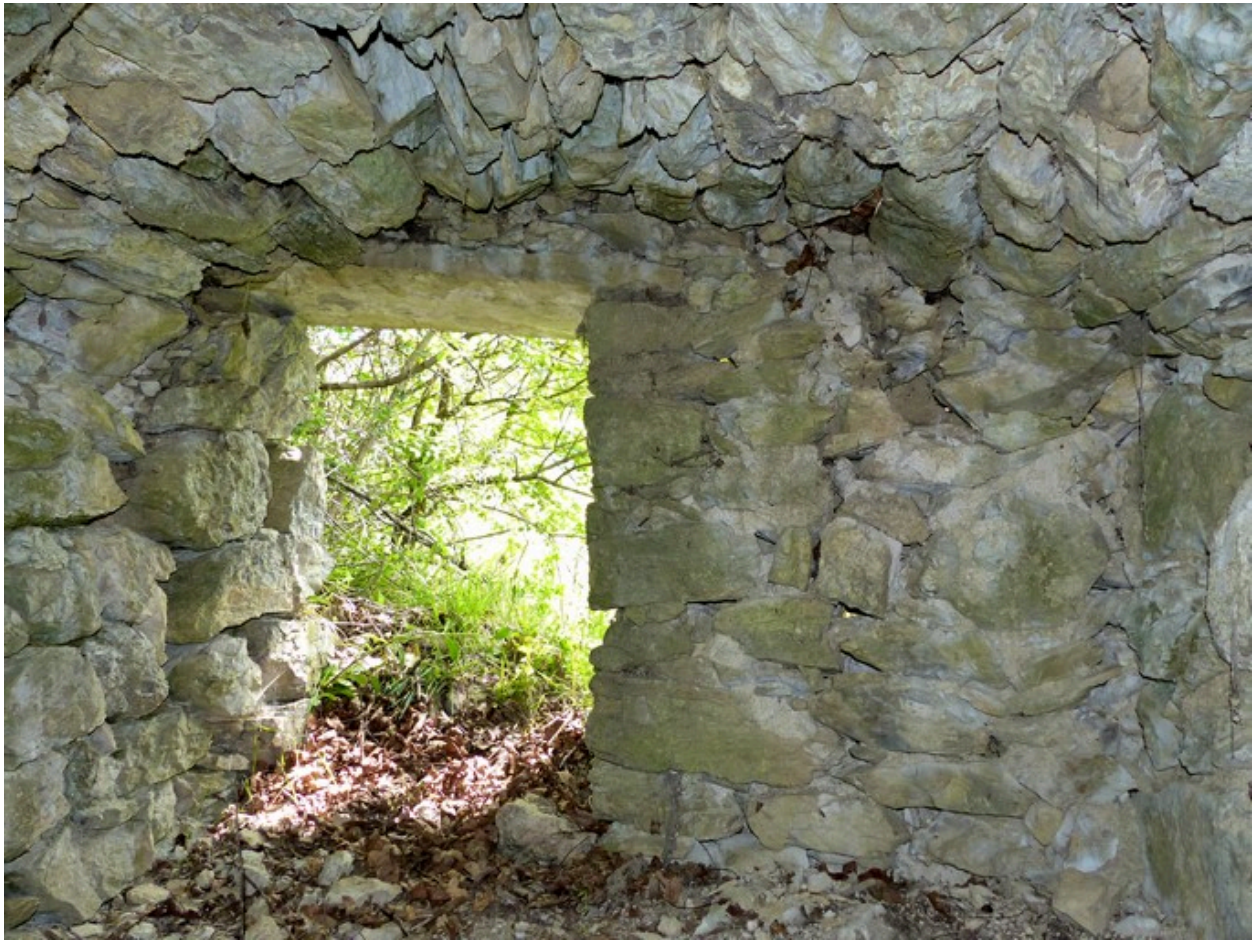
Vue de volume prise de l'ouest.
