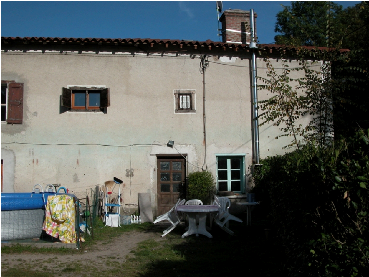
Vue du logis, partie sud.
