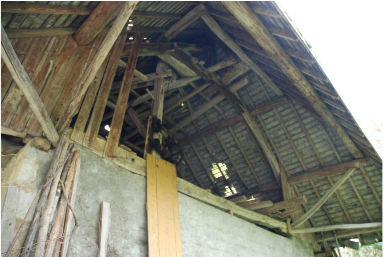
Vue de l'accès au fenil : treuil à foin.
