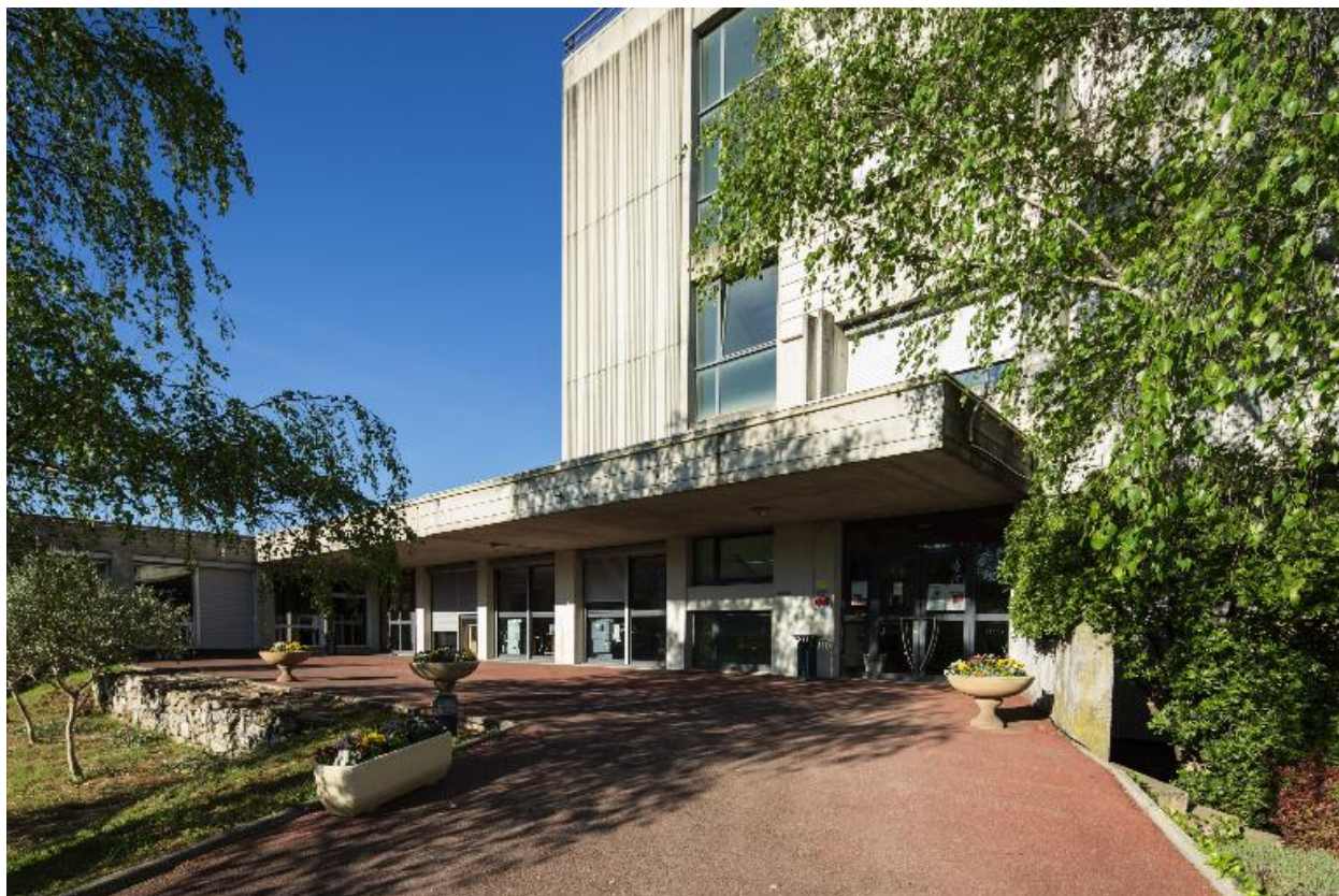
Bâtiment nord : entrée administrative.
