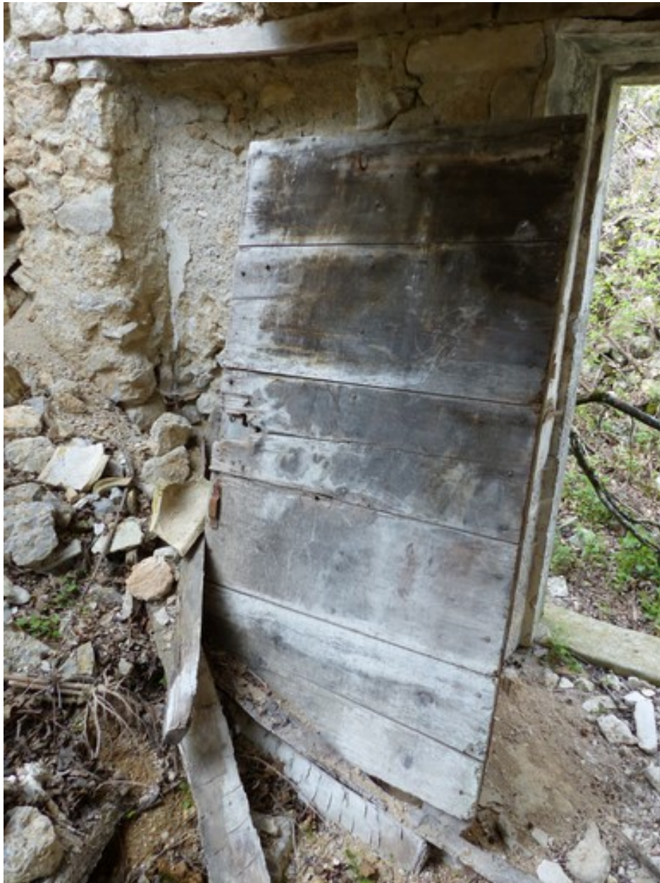
Rez-de-chaussée surélevé, logis. Mur nord, porte.
