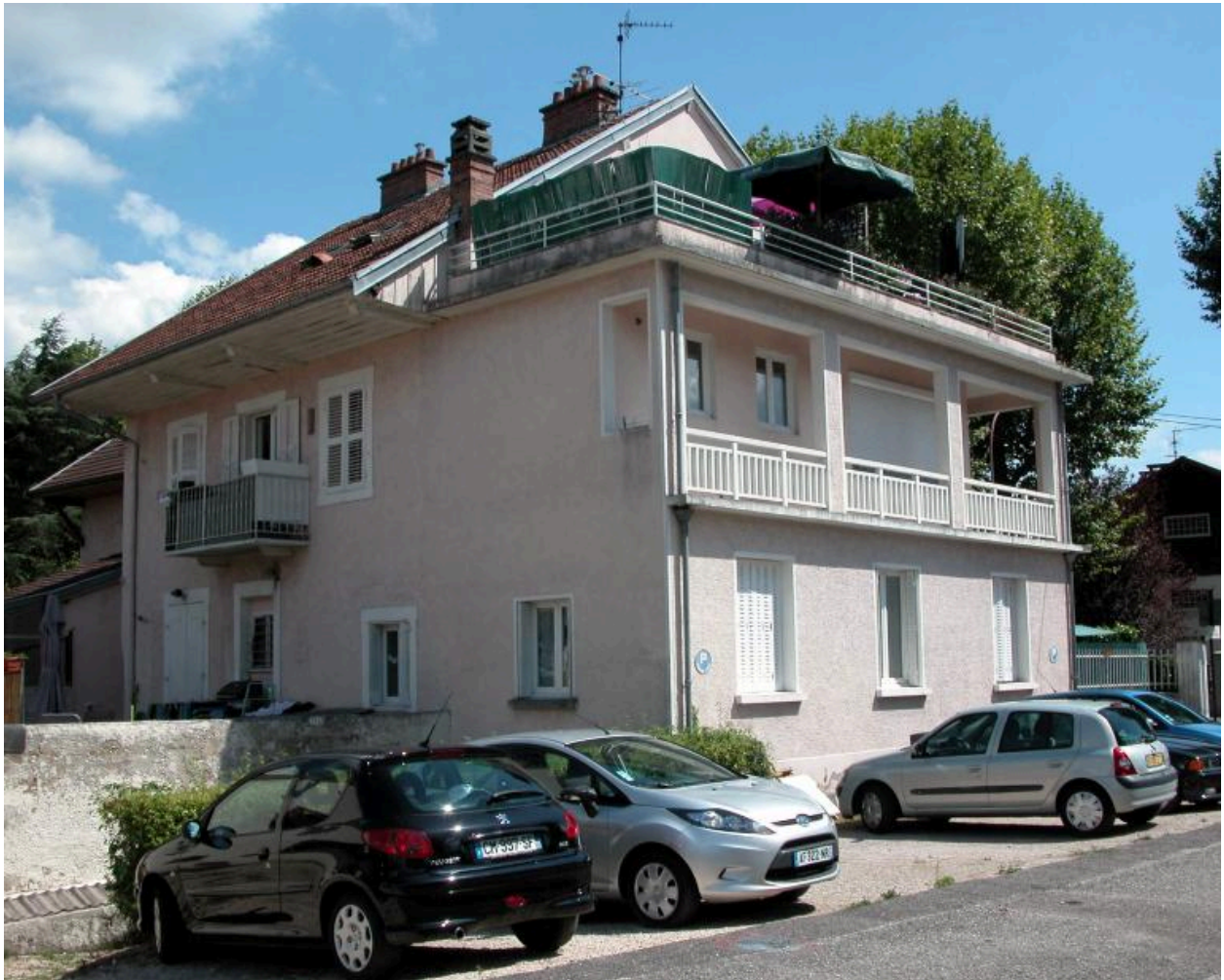
Façade postérieure (nord) et latérale (ouest)
