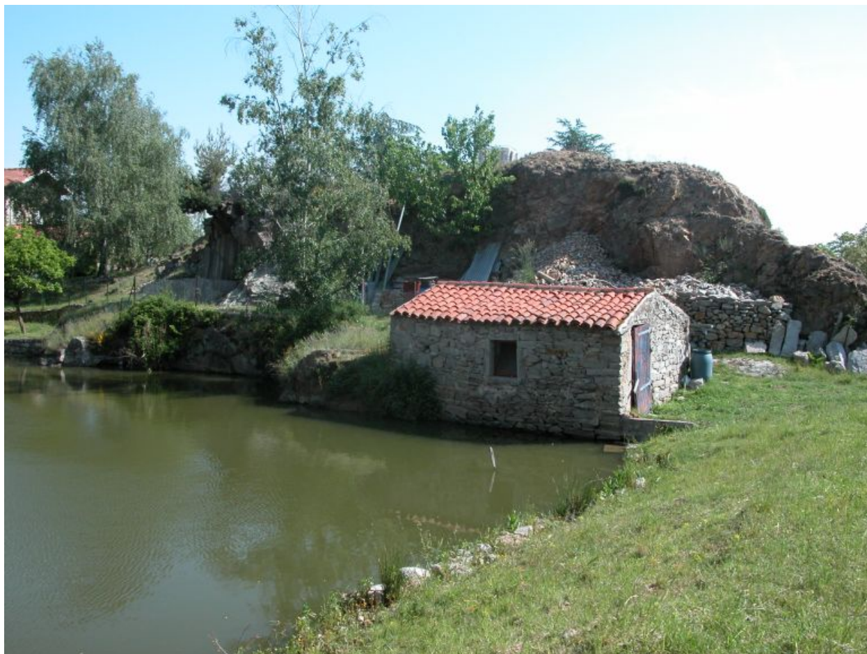
Vue d'ensemble de la pompe (1986 AS 241).
