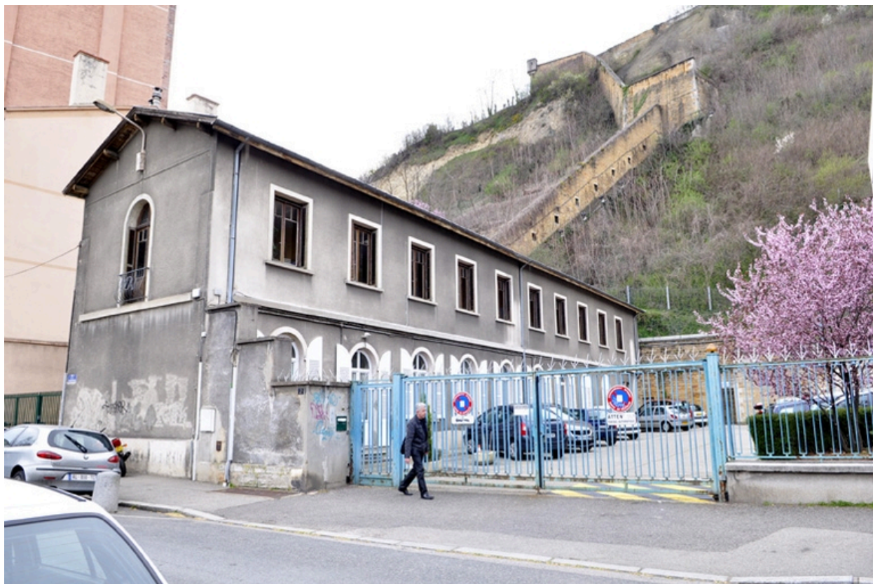
Ancien bâtiment ONN rue de la quarantaine
