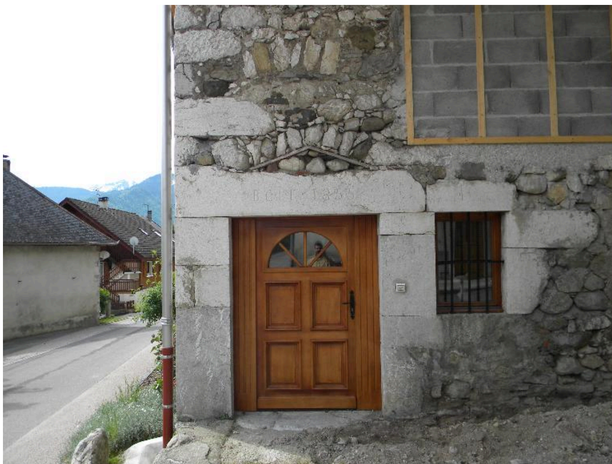
Vue des encadrement avec piédroit commune de porte et fenêtre (2008 A5 834)
