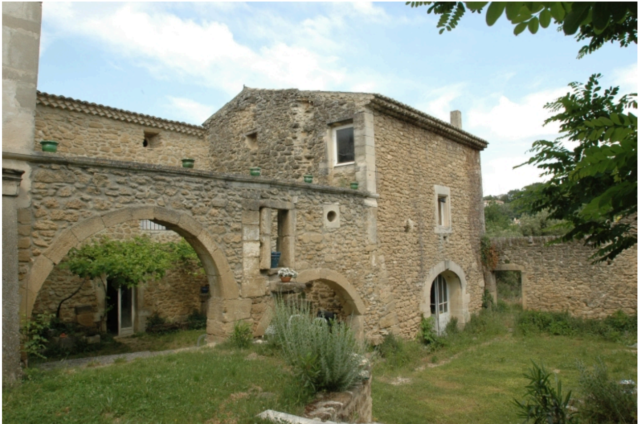
Vue sud-ouest du portail et de la magnanerie
