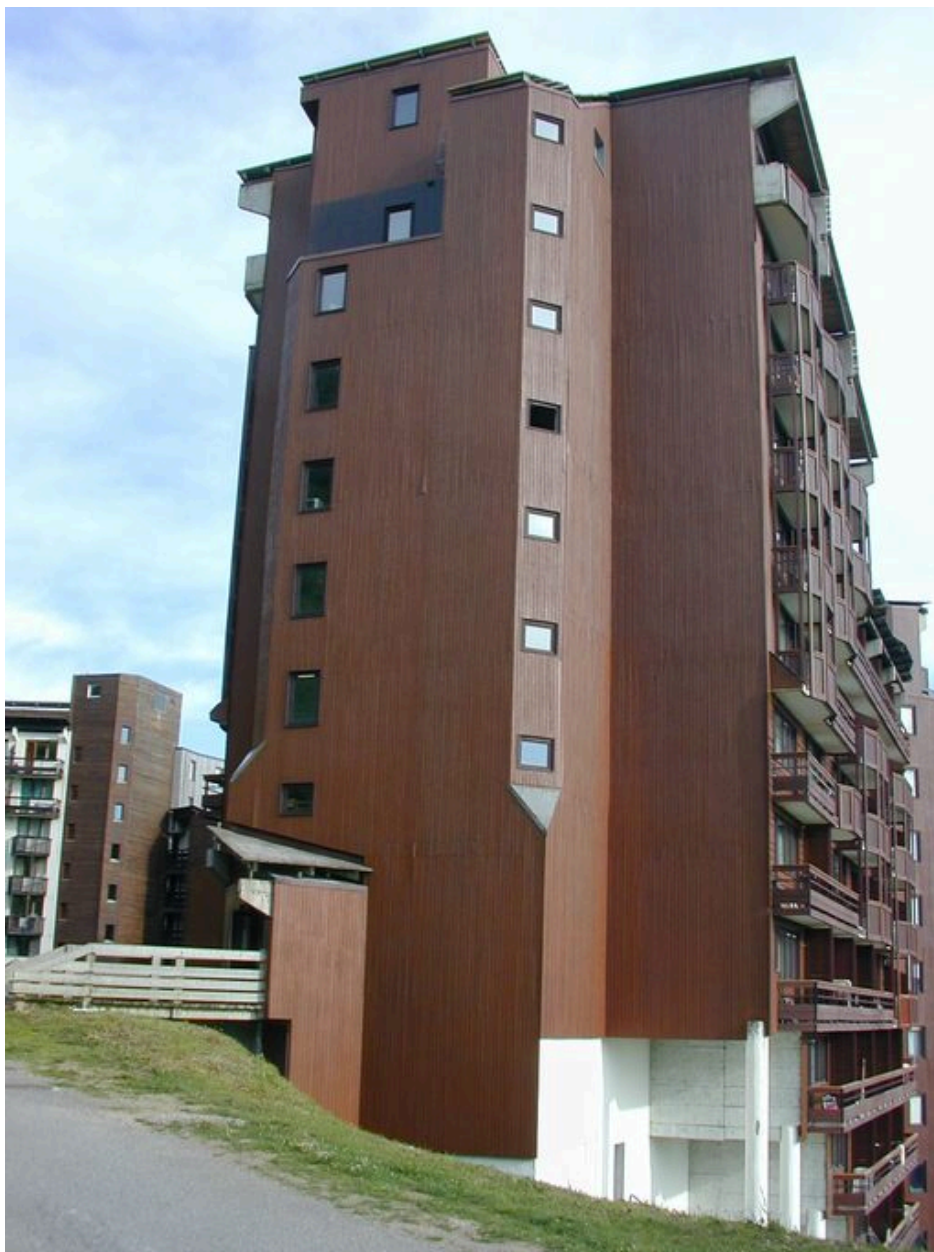
Vue du pignon nord
