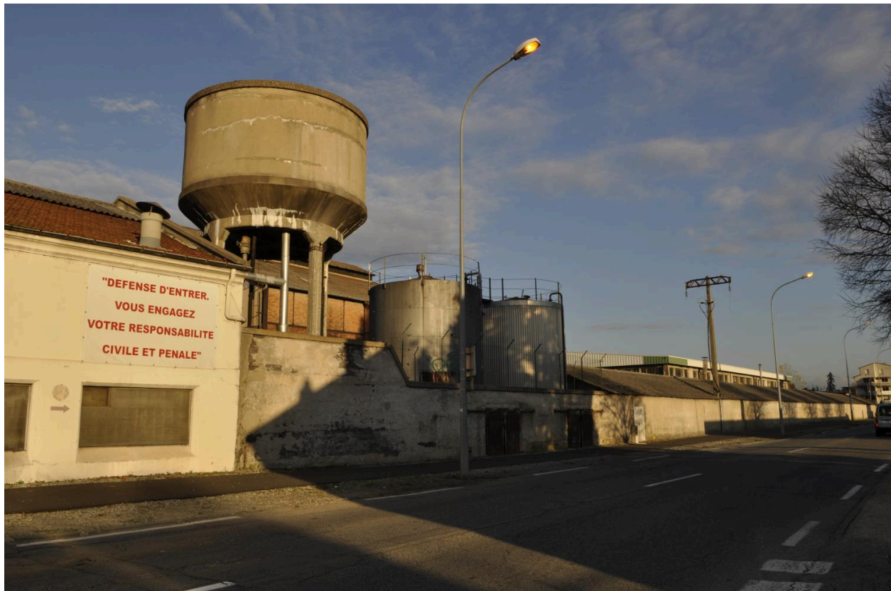
Vue du château d'eau
