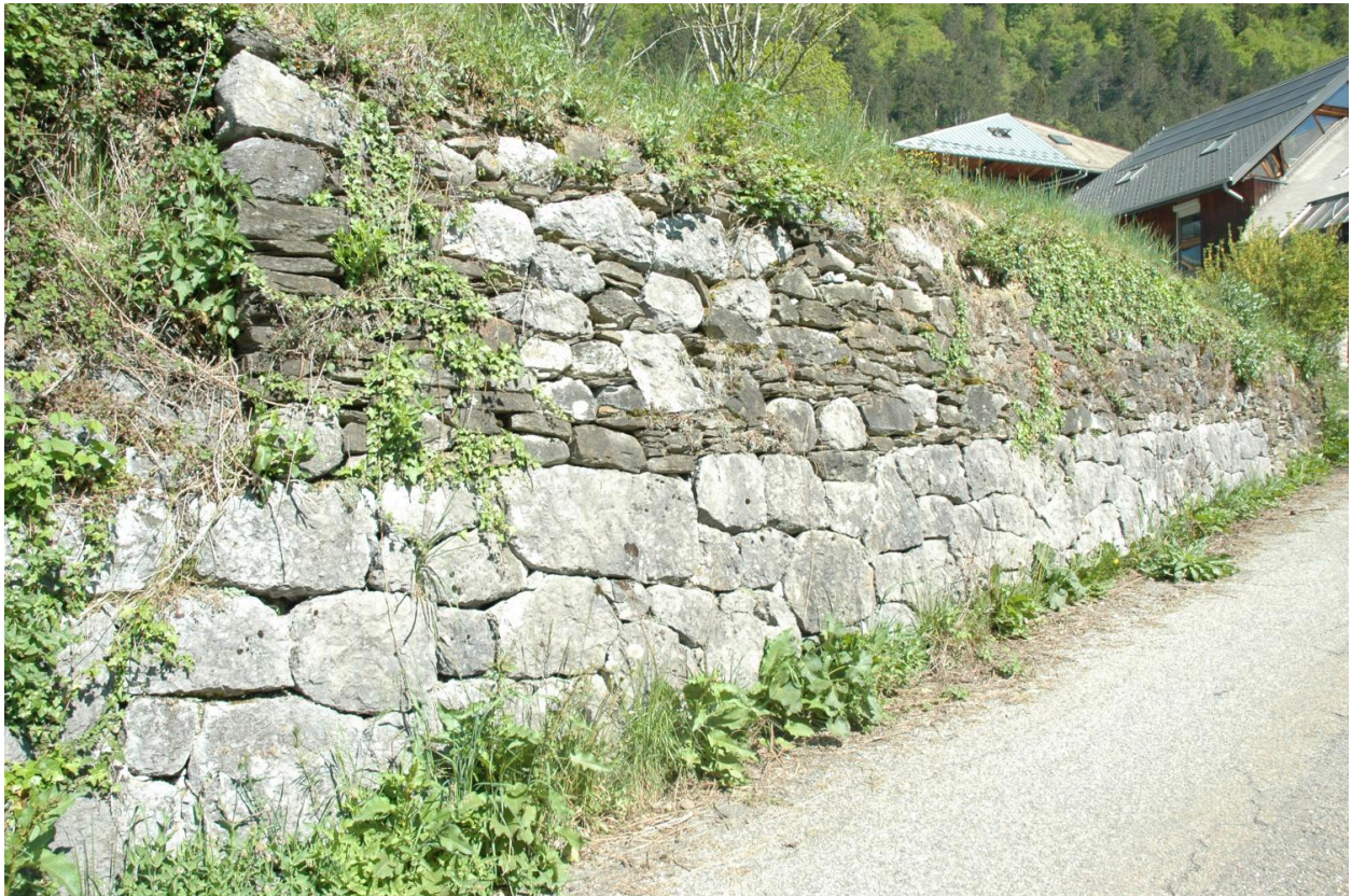
Vue de la route entre Mont-Benoît-dessus et Mont-Benoît-du-Milieu : talus retenu par un mur de pierre sèche.
