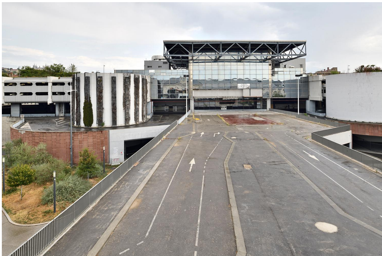
Eté 2026 : l'élévation sud du centre commercial
