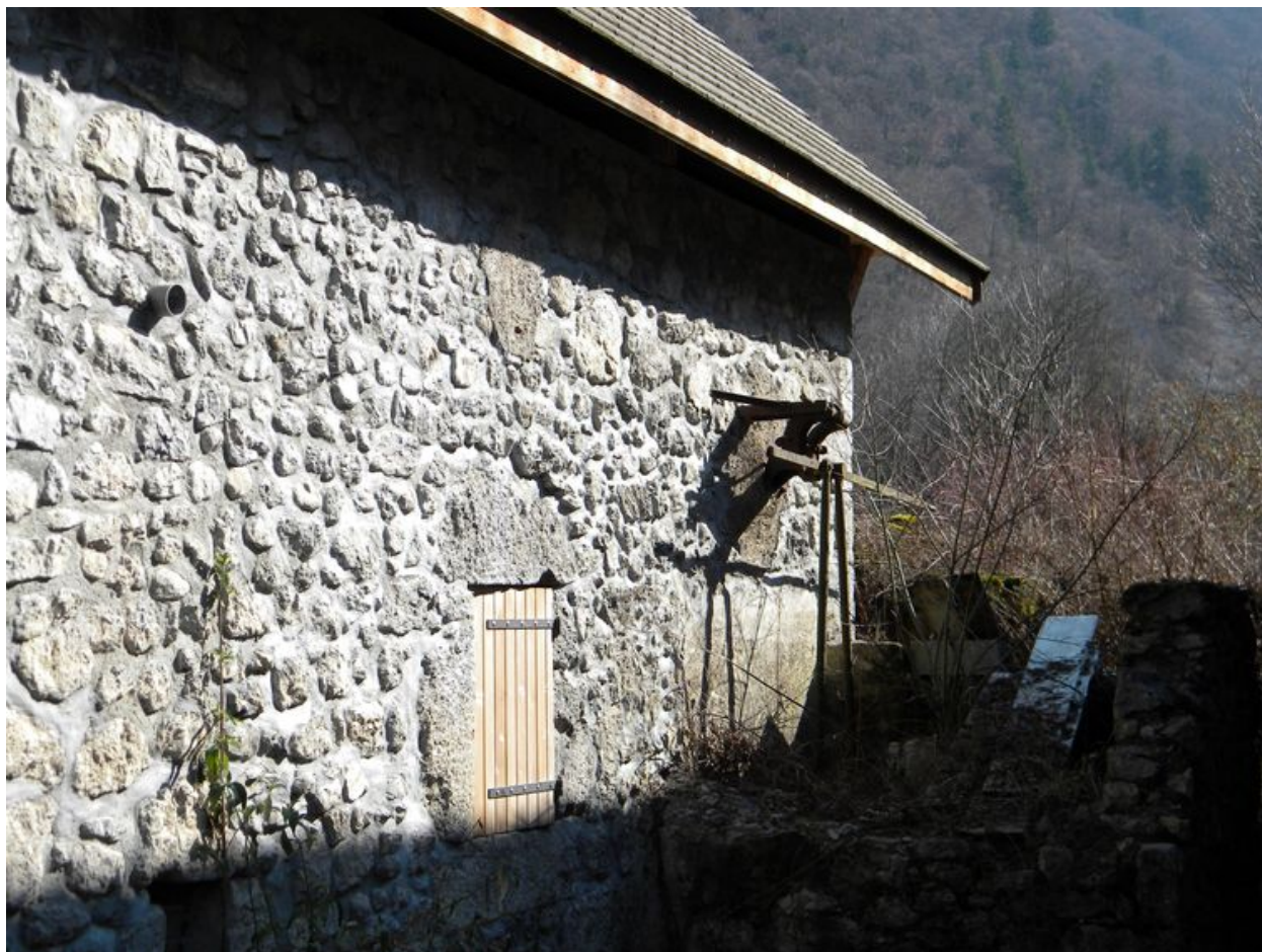
Vue de la façade sud de l'ancien moulin transformé avec l'arbre de la roue hydraulique apparent.
