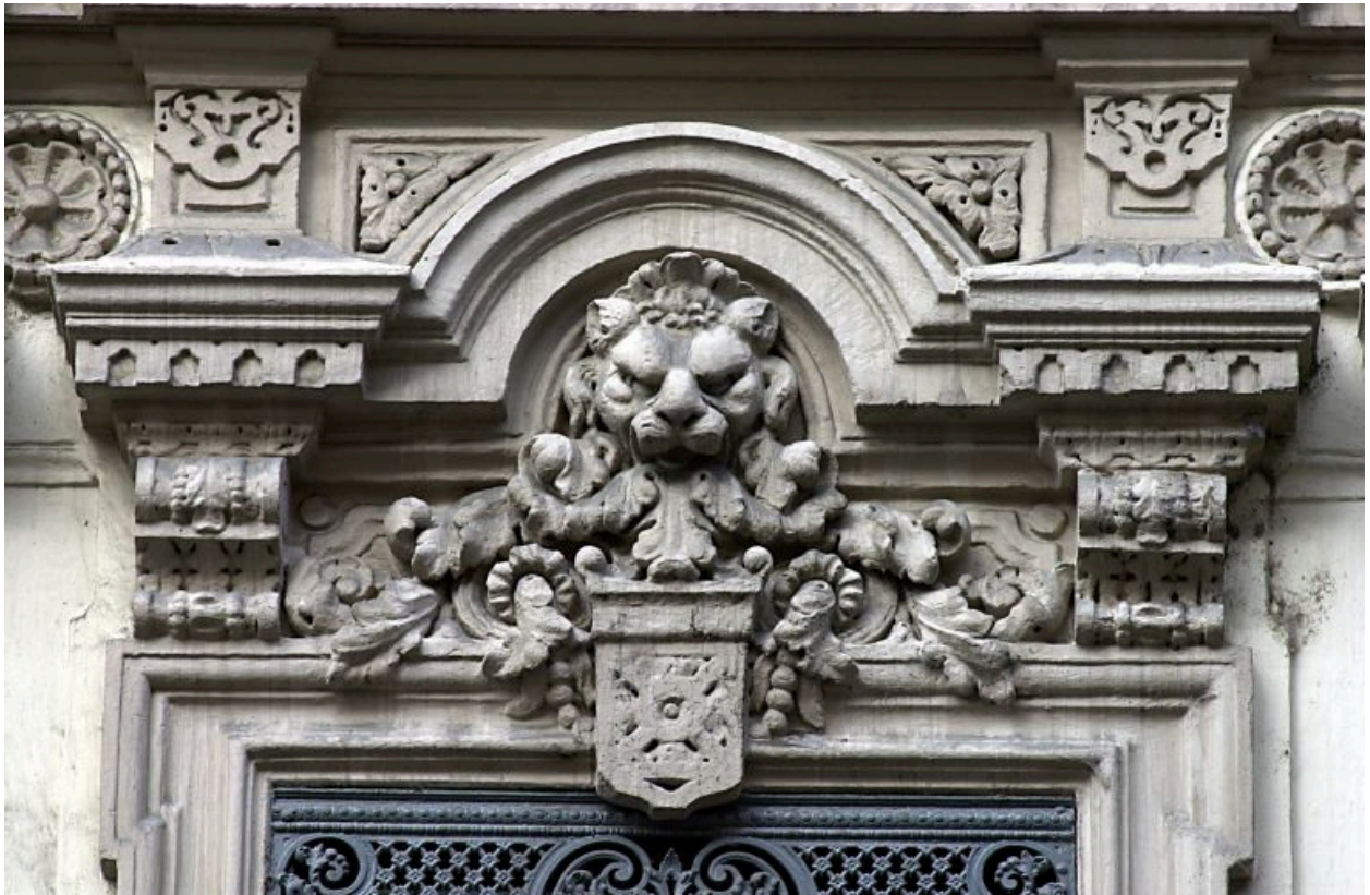
Façade, détail d'une fenêtre du 1er étage
