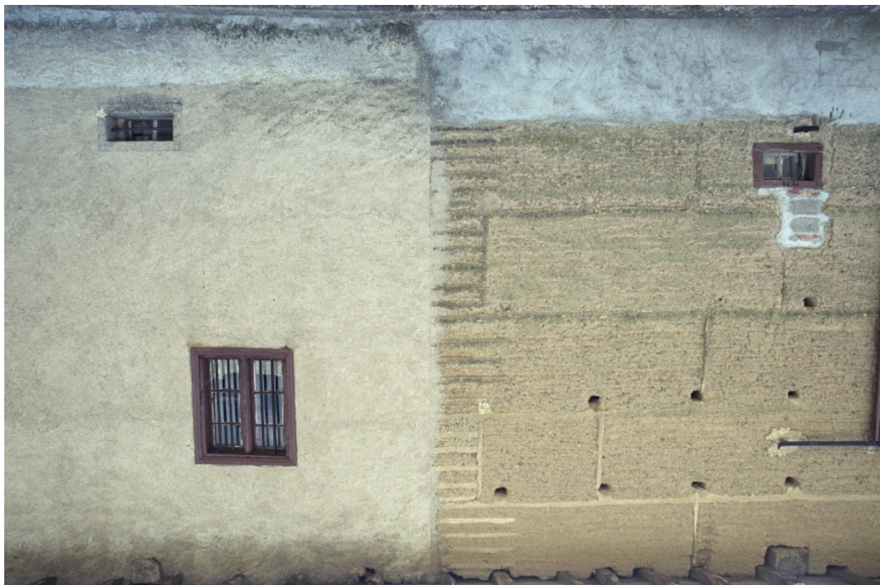
Bussy-Albieux, Gouttebelin (1987 D2 1225), type A1. Logis, vue arrière, détail des matériaux, pisé 18e siècle.
