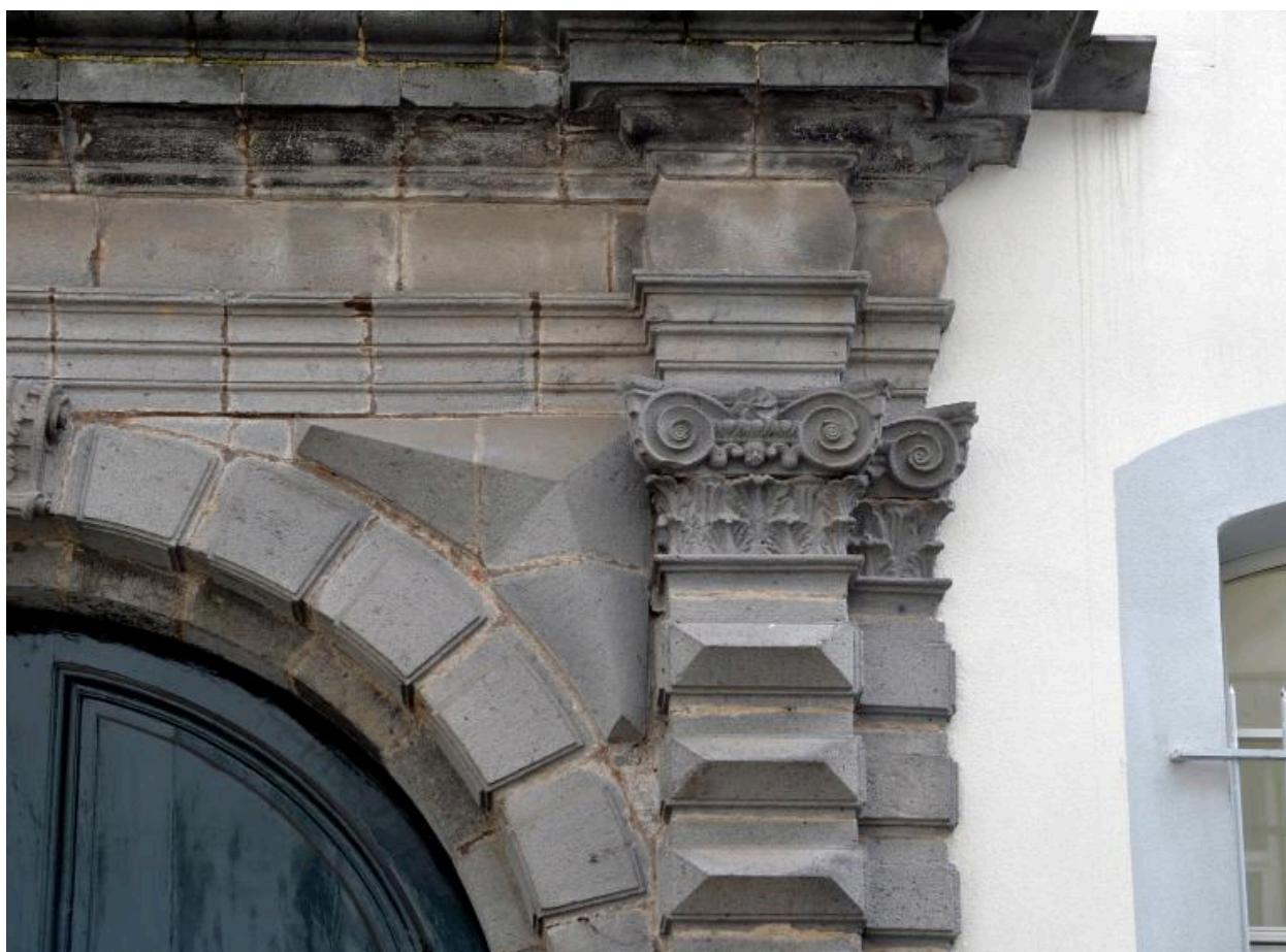
Porte sur rue : détail
