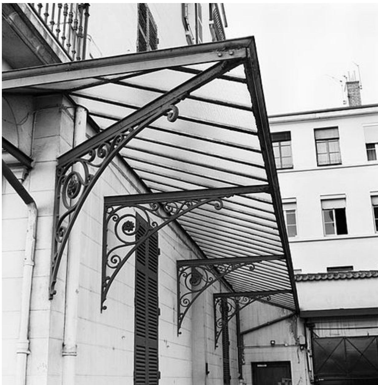
Façade latérale côté portail d'entrée, marquise
