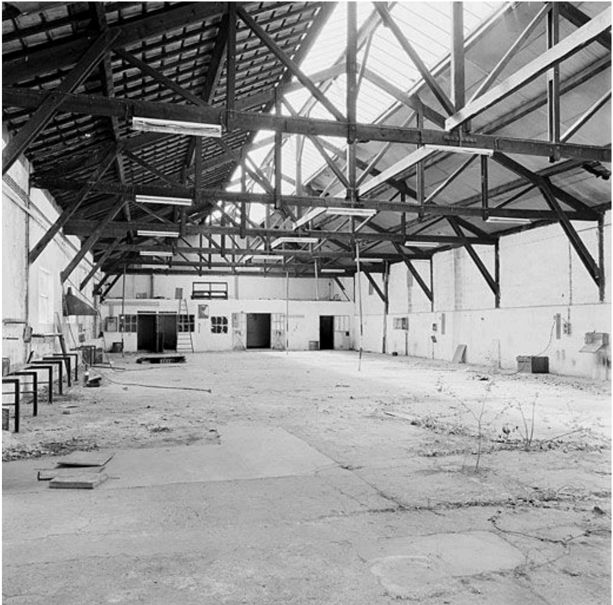
Entrepôts: garage, intérieur
