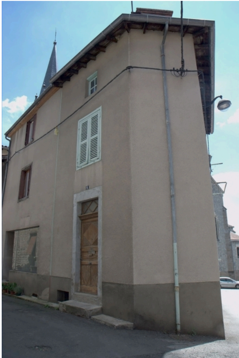
Îlot 6. Veloutiers (rue des) 06. Vue générale de la façade sur rue.
