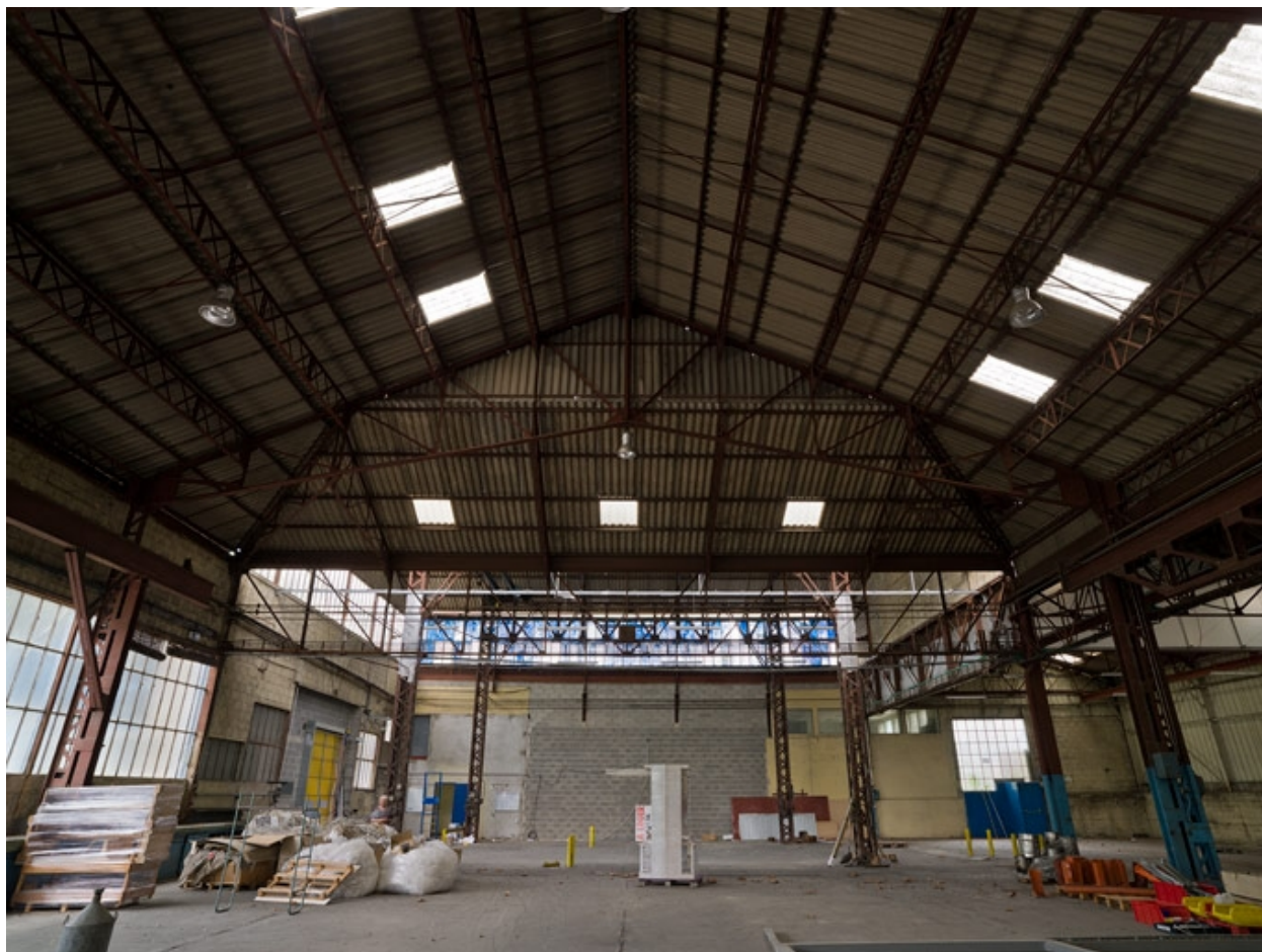
Vue intérieure des ateliers : charpente et structure métallique
