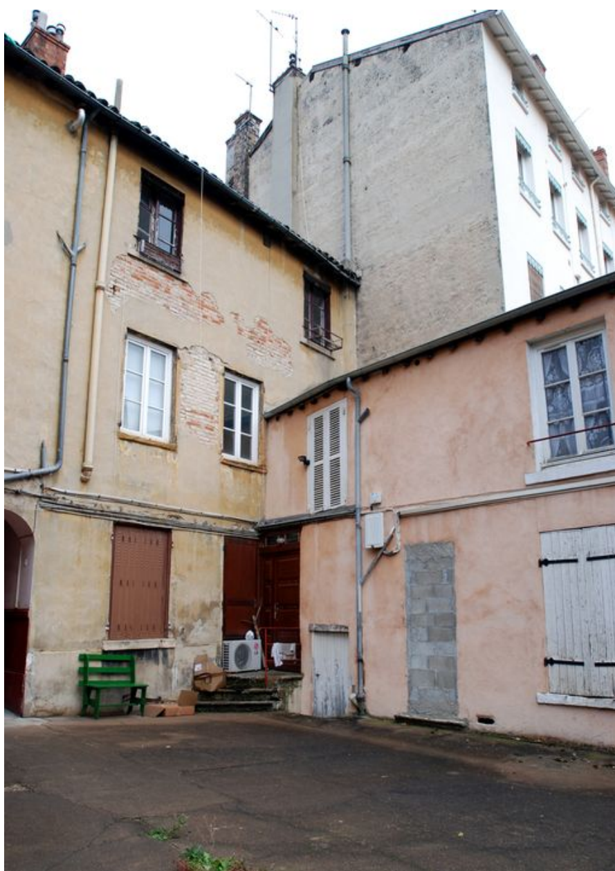
Elévation postérieure depuis le sud-ouest, détail
