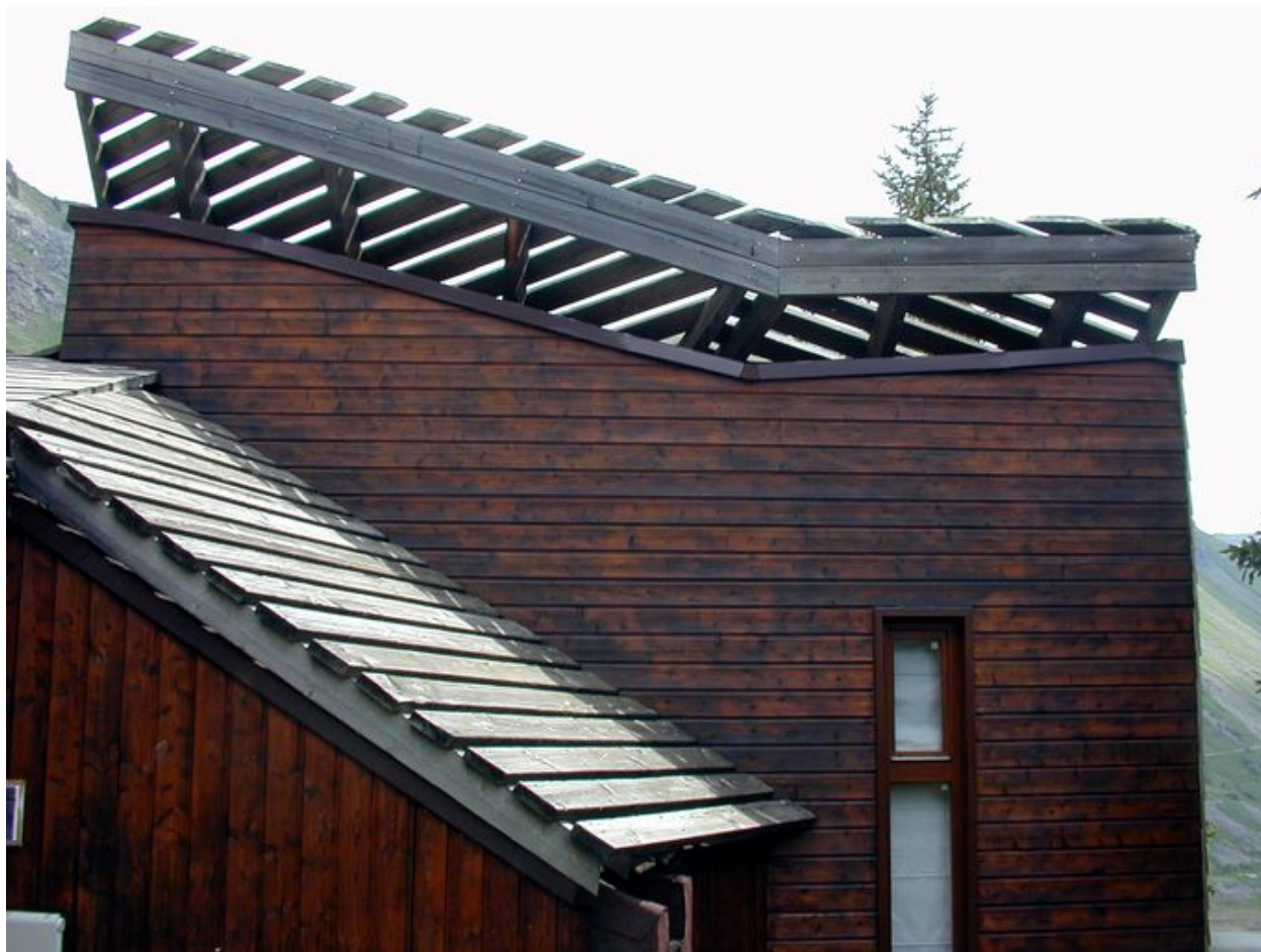
Détail de la toiture à pans inversés, vue depuis l'ouest
