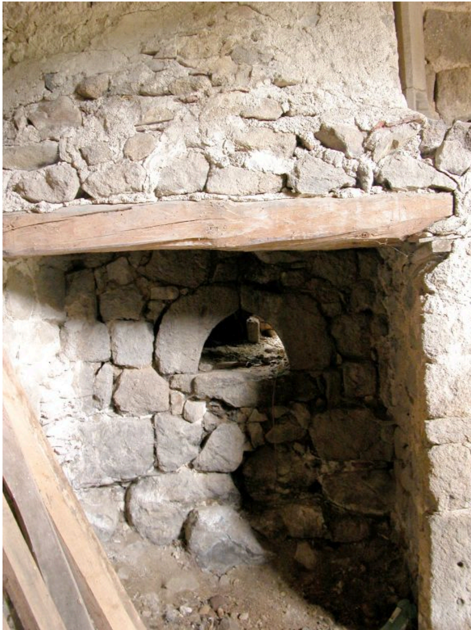
Rez-de-chaussée, côté droit, détail de la bouche du four à pain.
