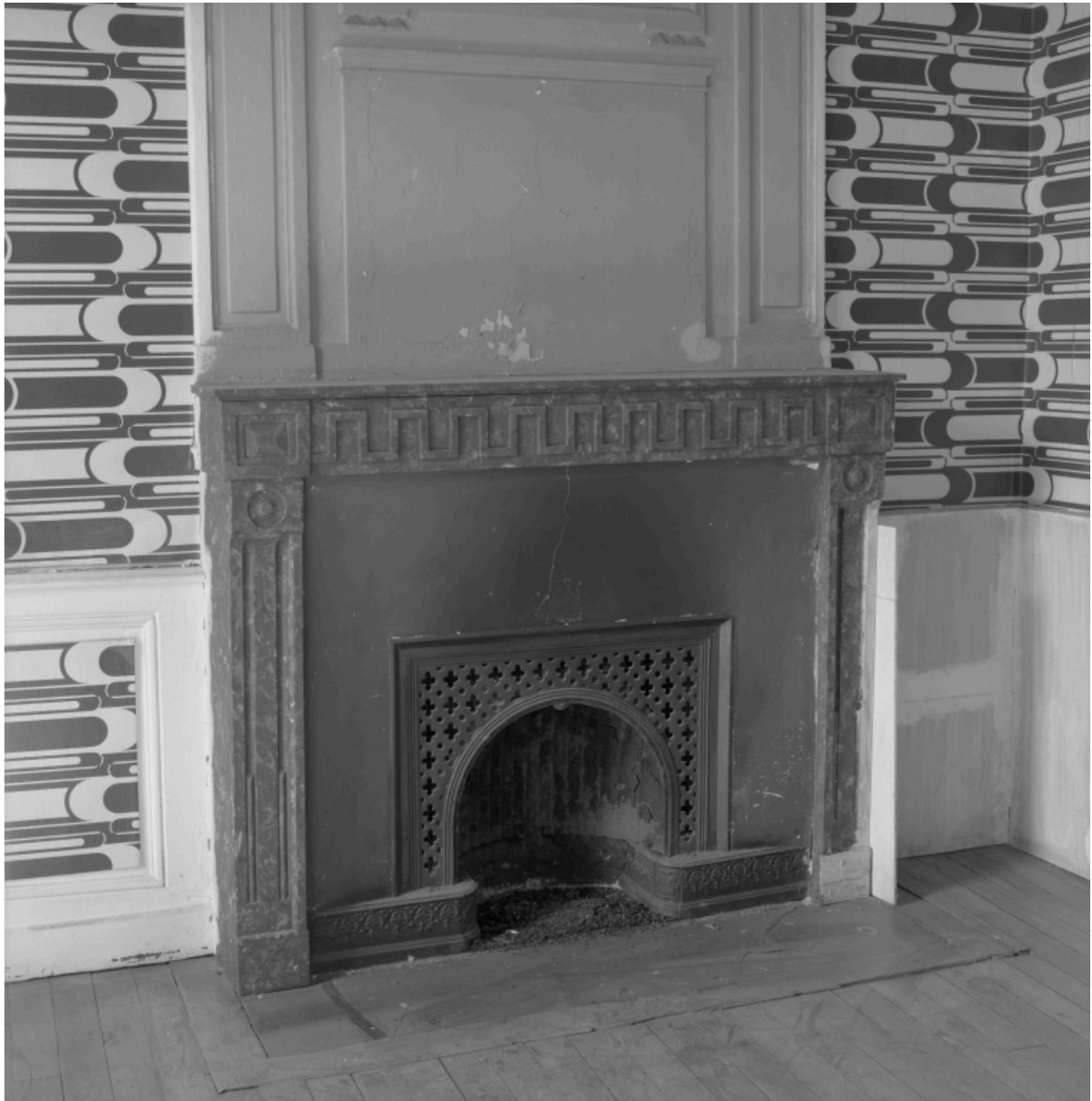
Vue intérieure de la chambre n°1 à l'étage : cheminée en bois peint.
