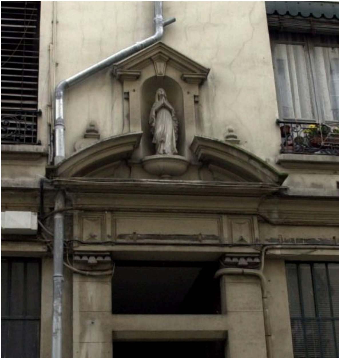
Détail du fronton de l'entrée de l'immeuble sur cour
