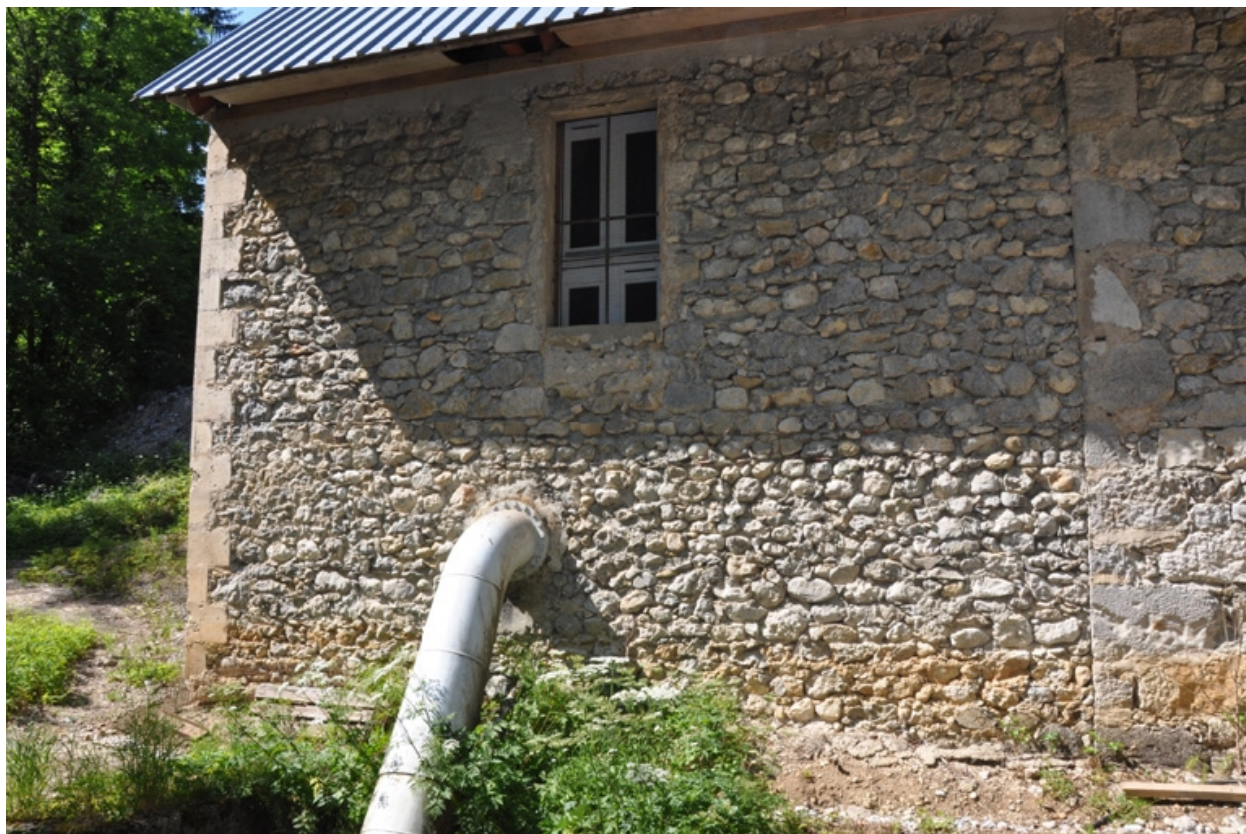
Détail de la façade sud avec l'extension de 1978
