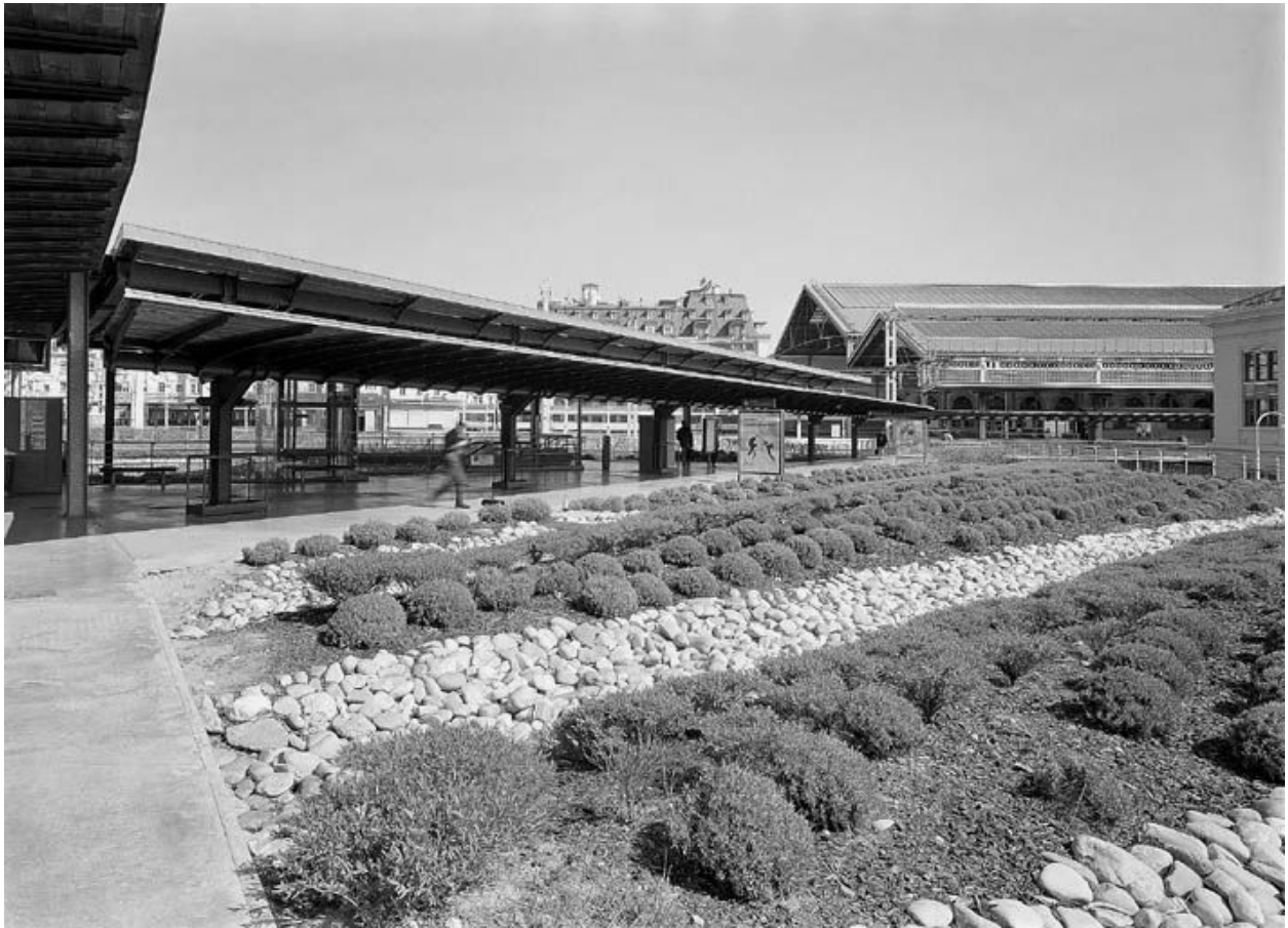
Les nouveaux quais desservant Saint-Etienne
